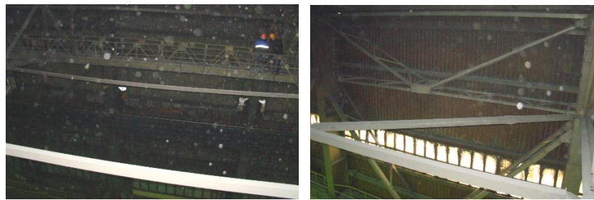
Рисунок 17 – Общее искривление распорок горизонтальных связей по нижним поясам ферм Ф7' – Ф8' пролета Б–В и местное искривление диагонали горизонтальной связи у А11' по нижним поясам ферм Ф11' – Ф12' пролета А–Б
