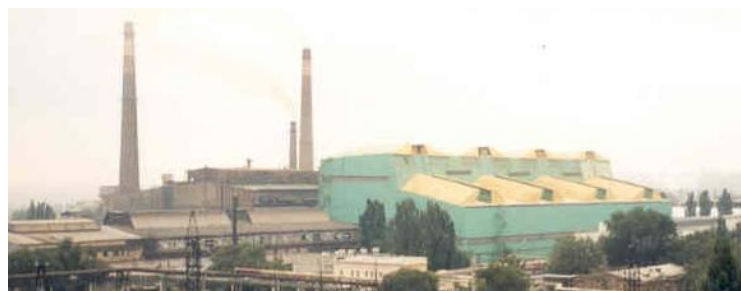
Рисунок 1 – Вид мартеновского цеха и здания отделения непрерывного литья заготовок (ОНЛЗ)
