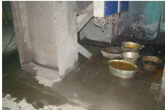
Рисунок 15 – Намокание основания колонны А9'
