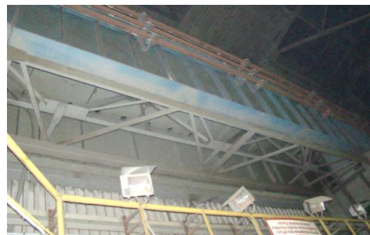
Рисунок 6 – Подкрановые балки с поперечными ребрами и тормозными конструкциями, состоящими из вспомогательных и связевых ферм
