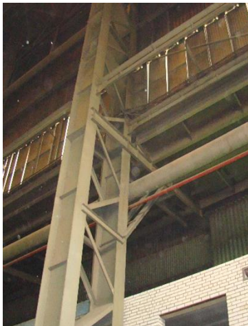
Рисунок 4 – Колонна по ряду А с кронштейном (а), по ряду В (б) и вертикальная связь между колоннами по ряду В (в)
