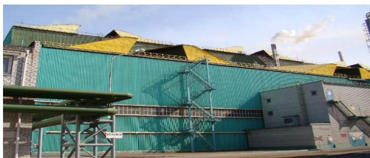
Рисунок 2 – Здание ОНЛЗ со стороны ряда В
