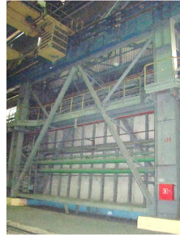
Рисунок 4 – Колонна по ряду А с кронштейном (а), по ряду В (б) и вертикальная связь между колоннами по ряду В (в)
