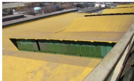
Рисунок 7 – Фонари на покрытии пролета Б–В
